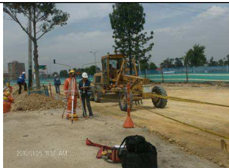
FOTO 5 Tramo 4-Subtramo 1 ICA Extendida del material granular sobre la vía.
