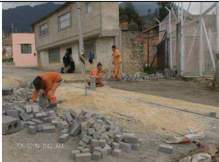
FOTO No 1 El espacio público está sin terminar. Se encuentra personal instalando adoquín.
