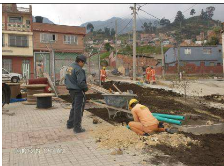
FOTO 3 Instalación de tubería y cableado para la subestación eléctrica.
