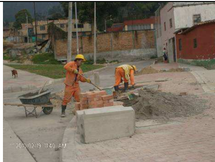
FOTO 2 El espacio público está sin terminar. Personal construyendo contenedores de raíces.
