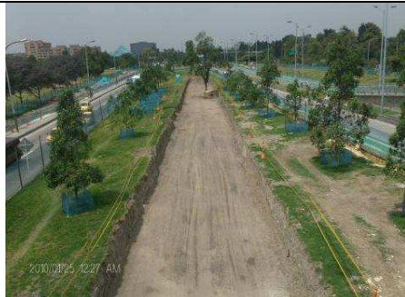
FOTO 3 Tramo 3 - Subtramo 5 Embajada Americana calzada Transmilenio sur. Frente inactivo.
