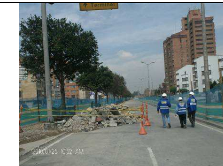
FOTO 6 Tramo 4-Subtramo 2. Puente vehicular Av. NQS calzada Transmilenio norte. Frente inactivo
