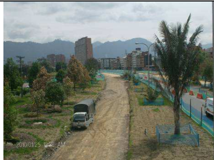
FOTO 4 Tramo 3-Subtramo 6 Calzada Transmilenio sur frente a la Embajada Americana. Frente inactivo
