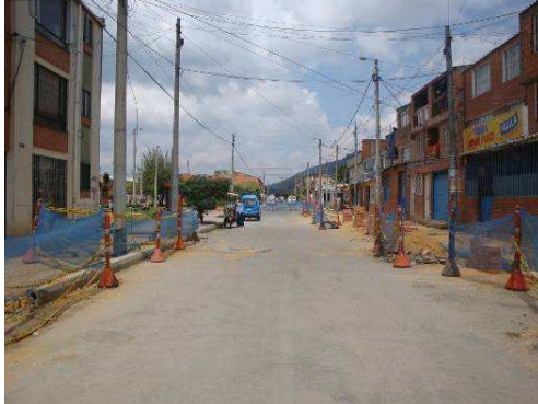
Falta por terminar capa de rodadura y espacio público Visita Fiscal 15 de febrero de 2010
