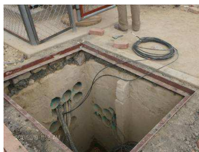
FOTO 4 Cableado para la subestación eléctrica.
