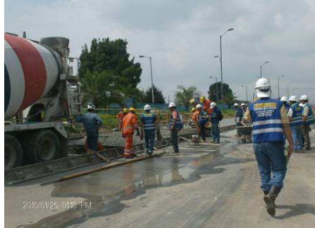
FOTO 1 Tramo 3 –Subtramo 1. Fundición de placas en concreto MR-45.
