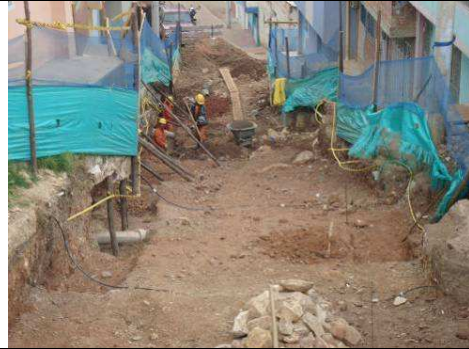
Visita Fiscal 15 de septiembre de 2009 Sin actividad en la obra
