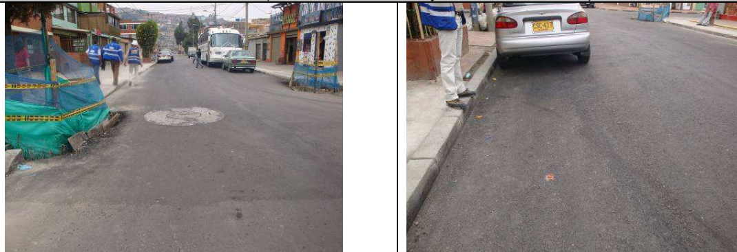
Falta terminar sumideros
